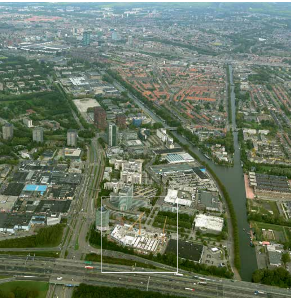
DE MERWEDEKANAALZONE Middenonder de bouw van het van der Valk Hotel
